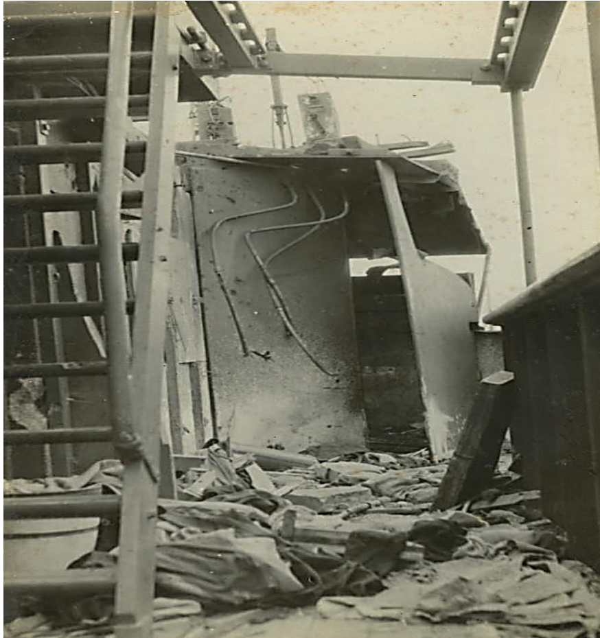
SCHADE AAN DE TANKER ONDINA
